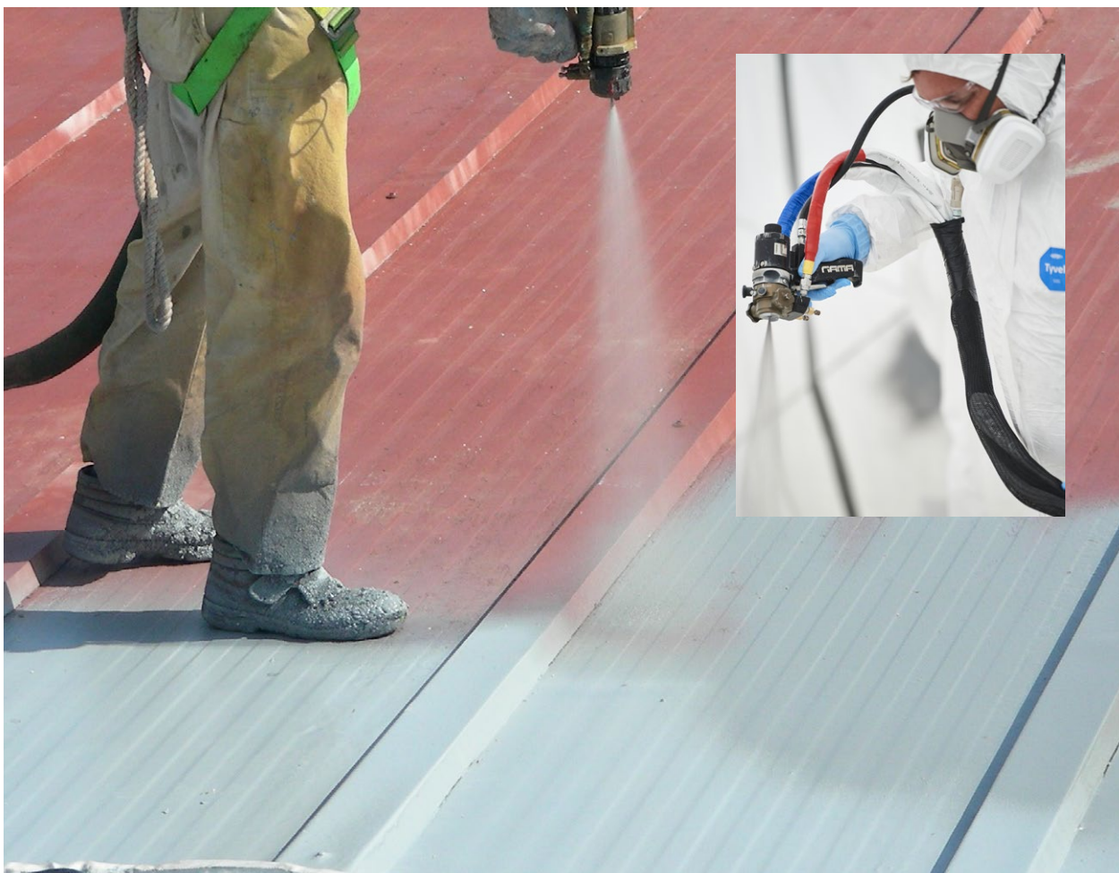
Proyección de la membrana de impermeabilización sobre chapa de panel sandwich
