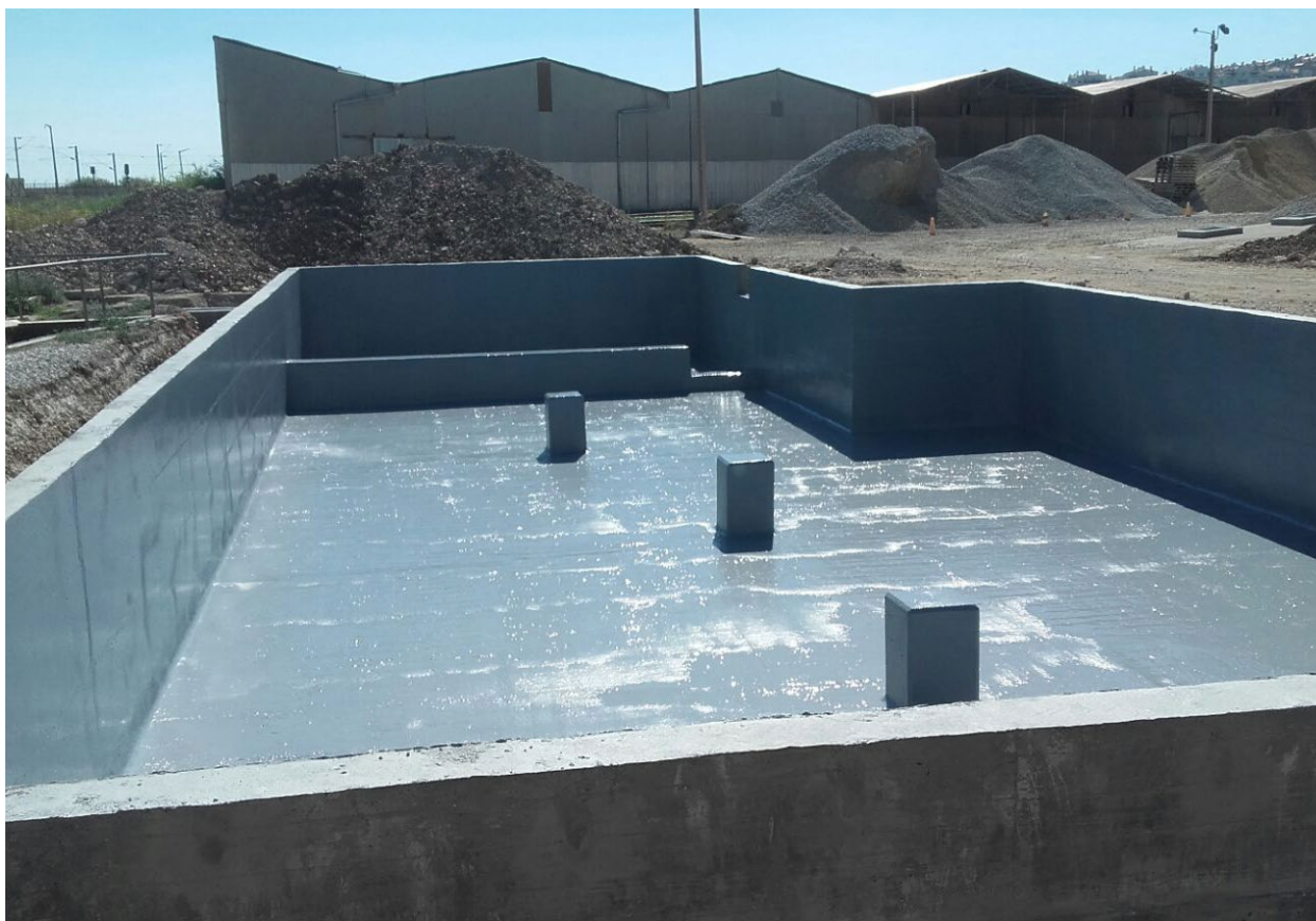
Poliurea aplicada sobre un soporte de hormigón imprimado
