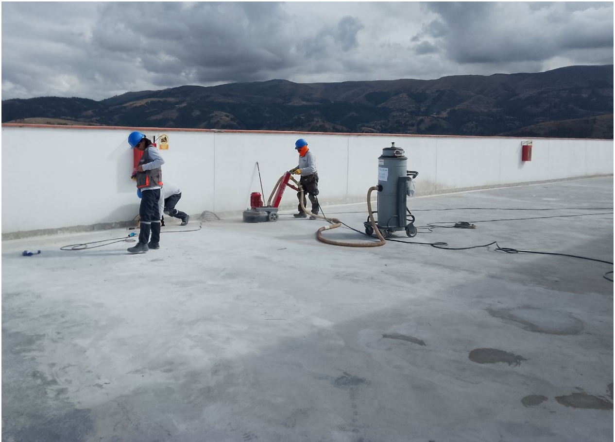
Regularización del soporte (lijado)
