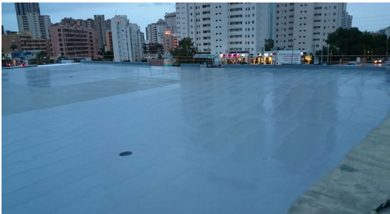
Cubierta plana impermeabilizada con poliurea sobre soporte de hormigón imprimado
