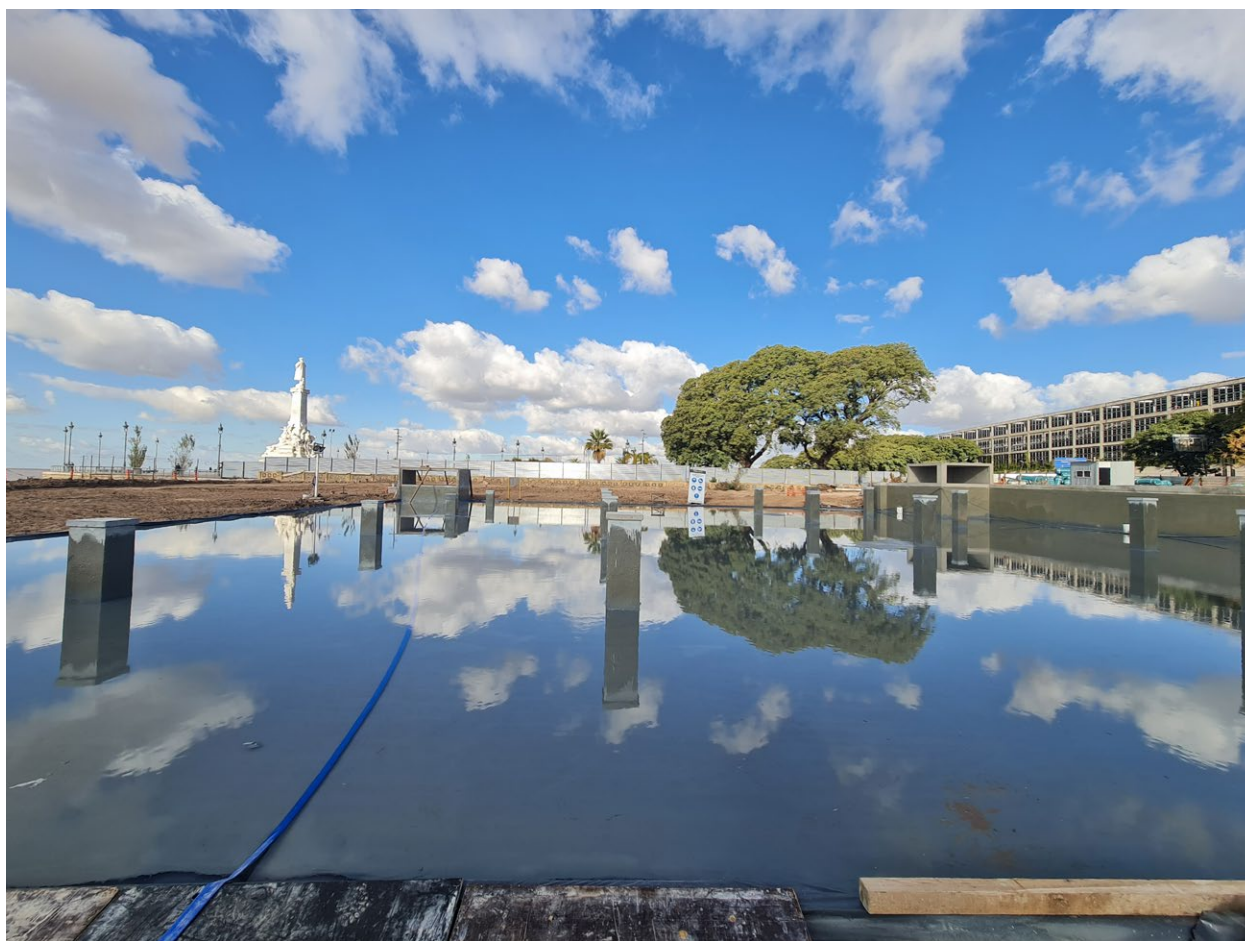
Ensayo de inundación en cubierta plana impermeabilizada con poliurea
