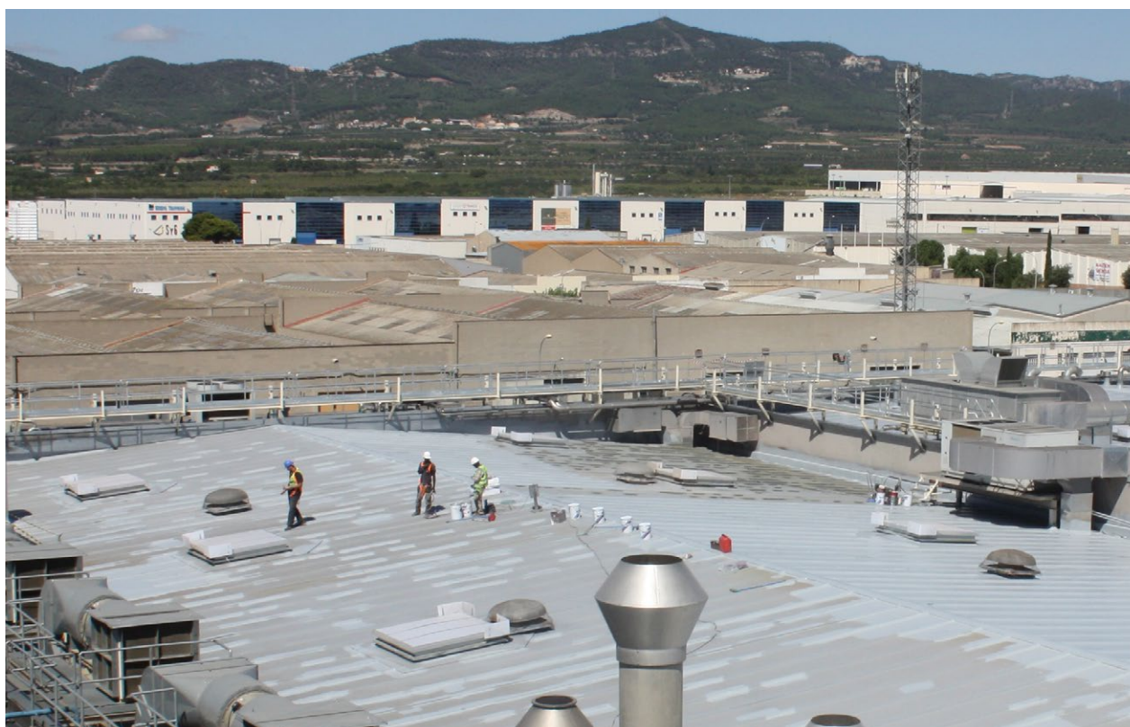
Preparación de soporte e imprimación de una cubierta de panel sandwich a dos aguas previa a la aplicación de la membrana de poliurea
