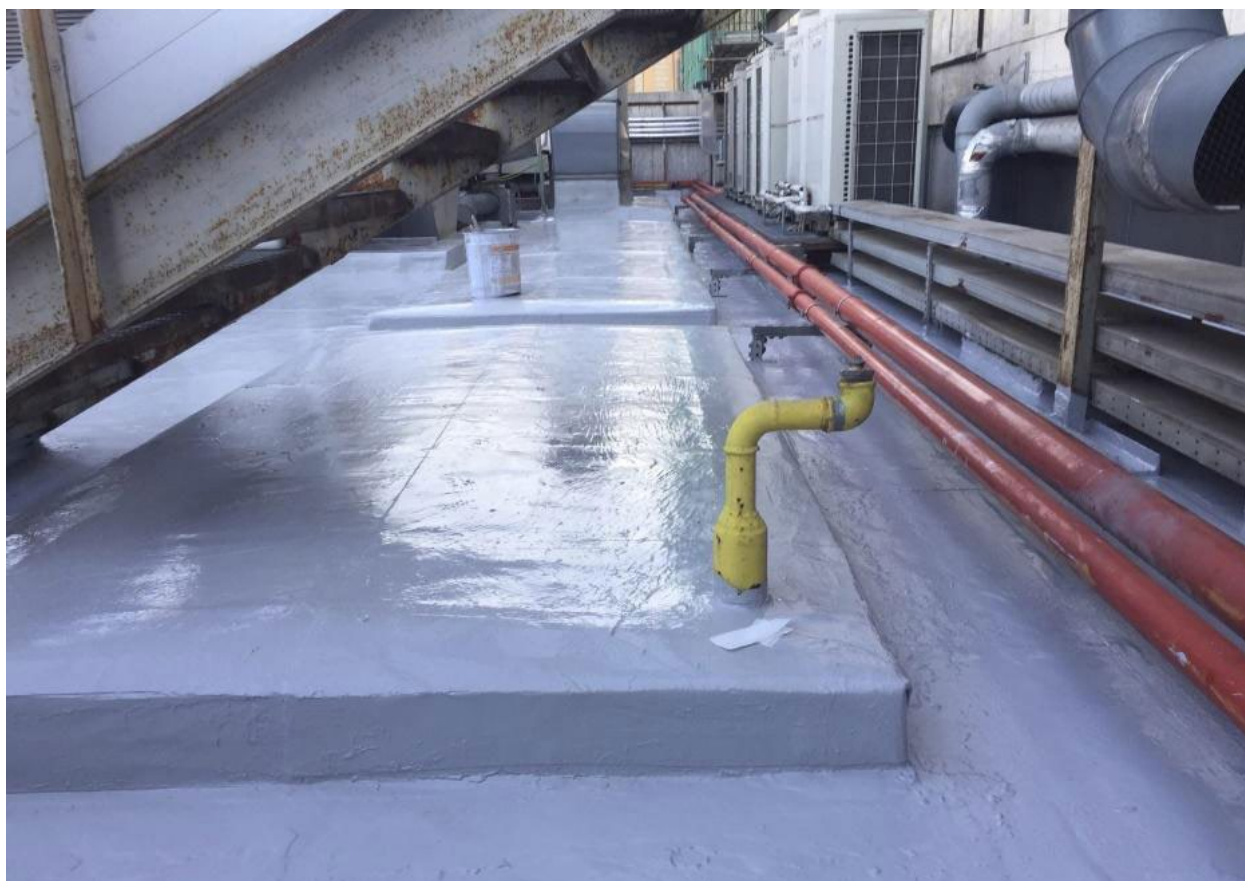
Cubierta impermeabilizada con poliurea
