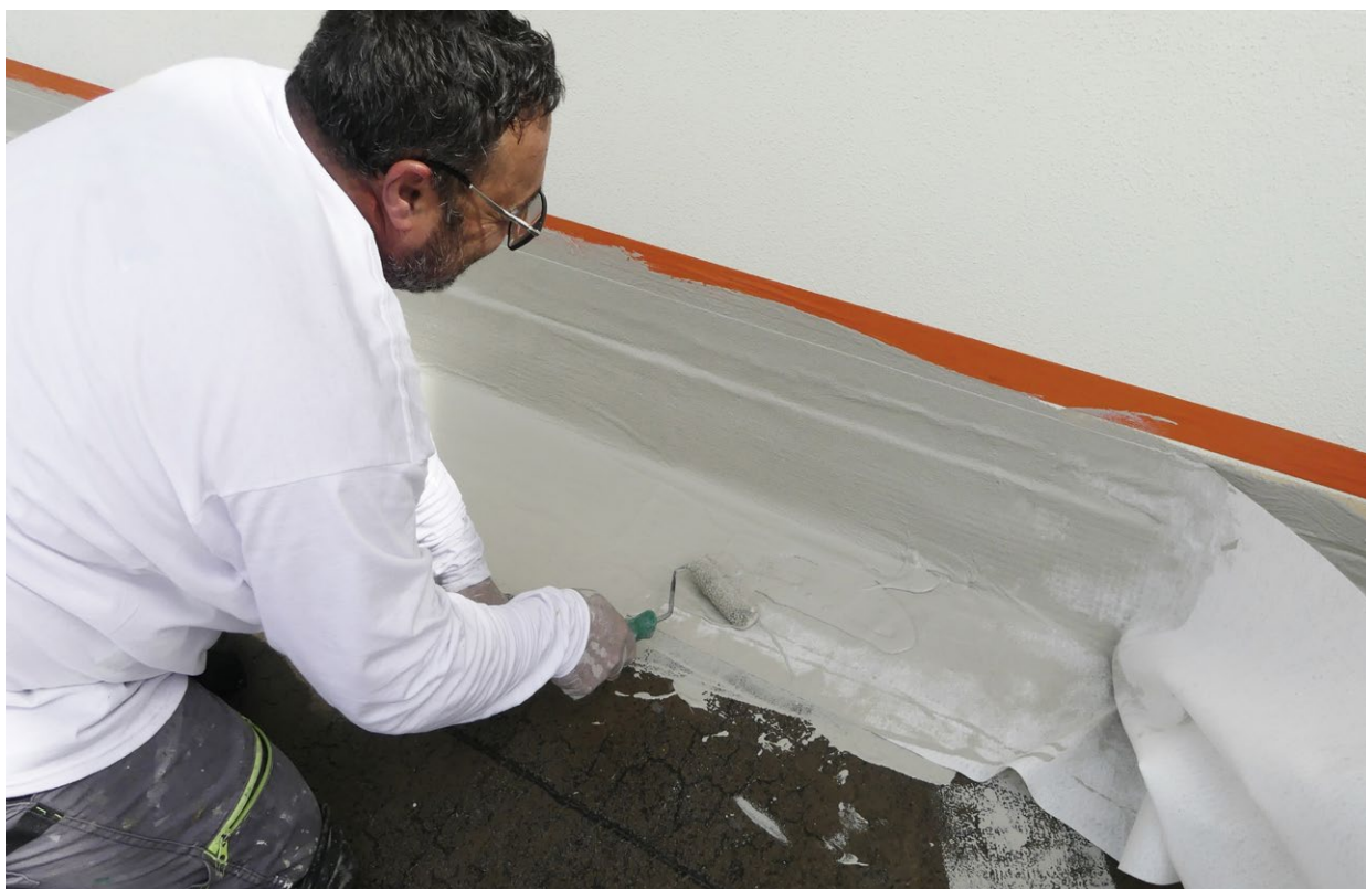
Realización de imprimación armada con refuerzo en remate vertical sobre superficie existente
