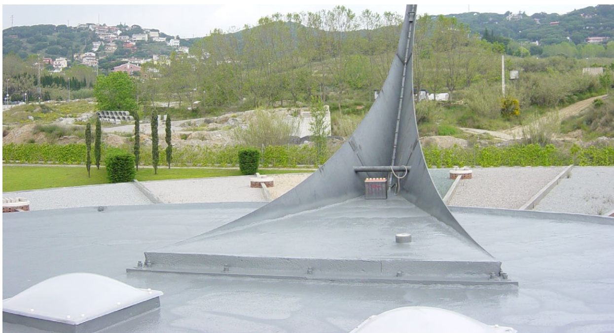
Cubierta impermeabilizada con poliurea
