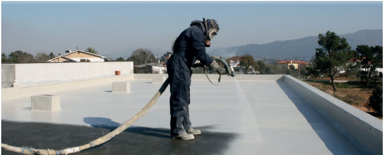
Aplicador proyectando poliurea con máscara completa con filtro
