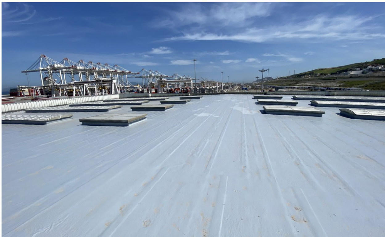
Rehabilitación de cubierta plana industrial en puerto marítimo
