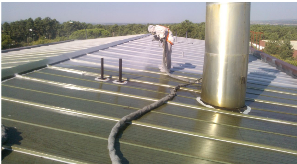
Impermeabilización de cubierta metálica con poliurea
