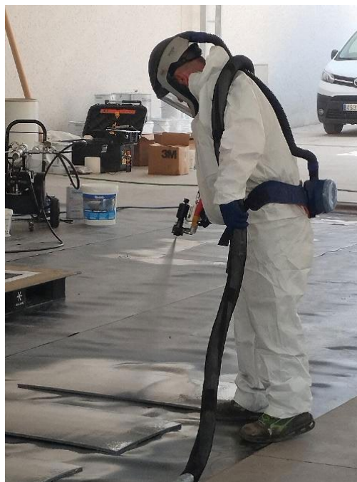
Operario equipado adecuadamente con EPI
