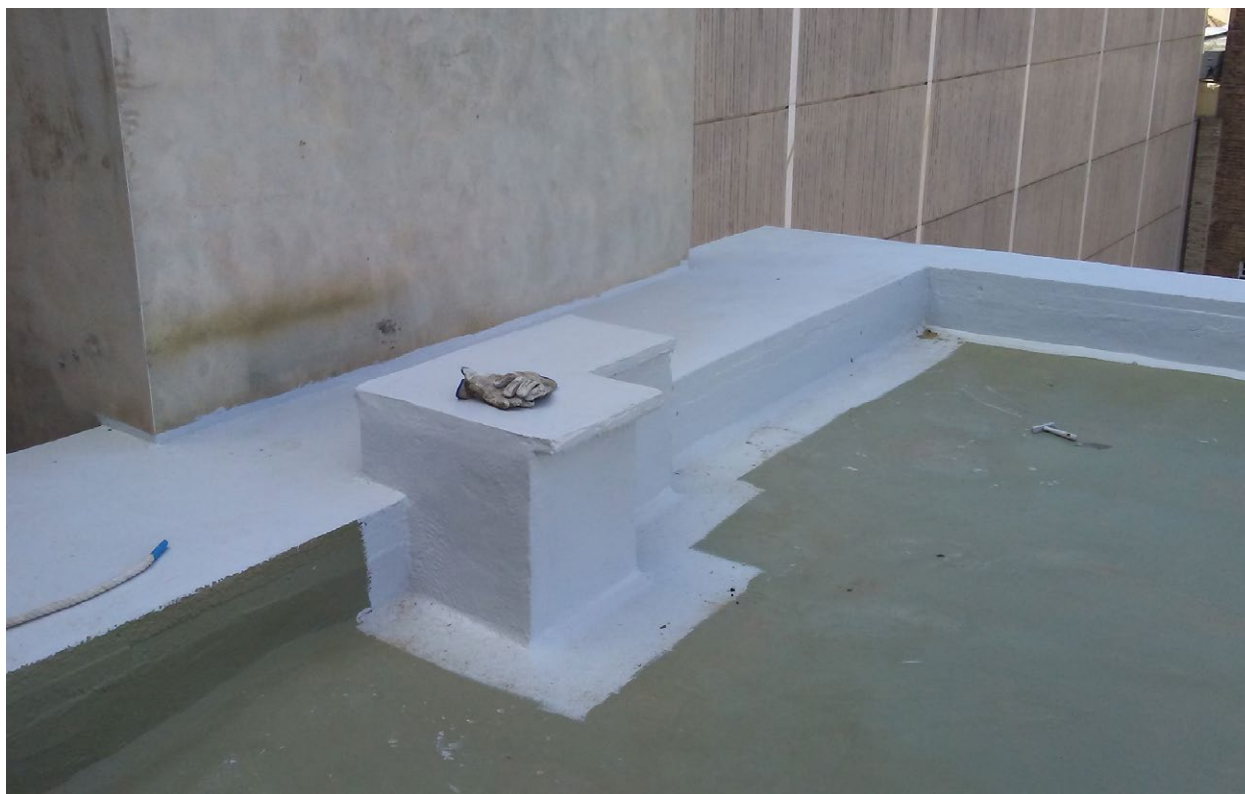
Realización de imprimación armada con refuerzo de fibras en remate vertical sobre superficie existente
