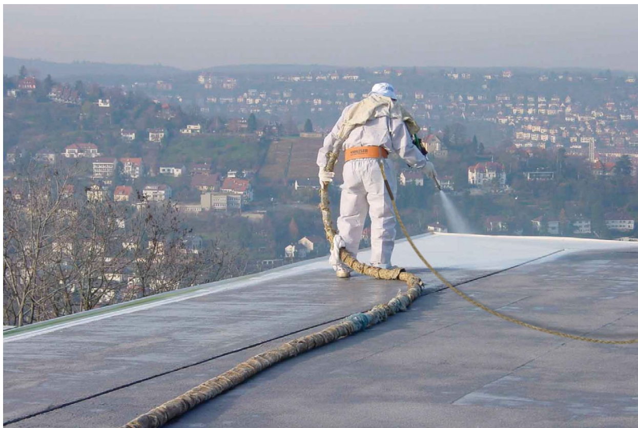
Impermeabilización con poliurea sobre lámina bituminosa
