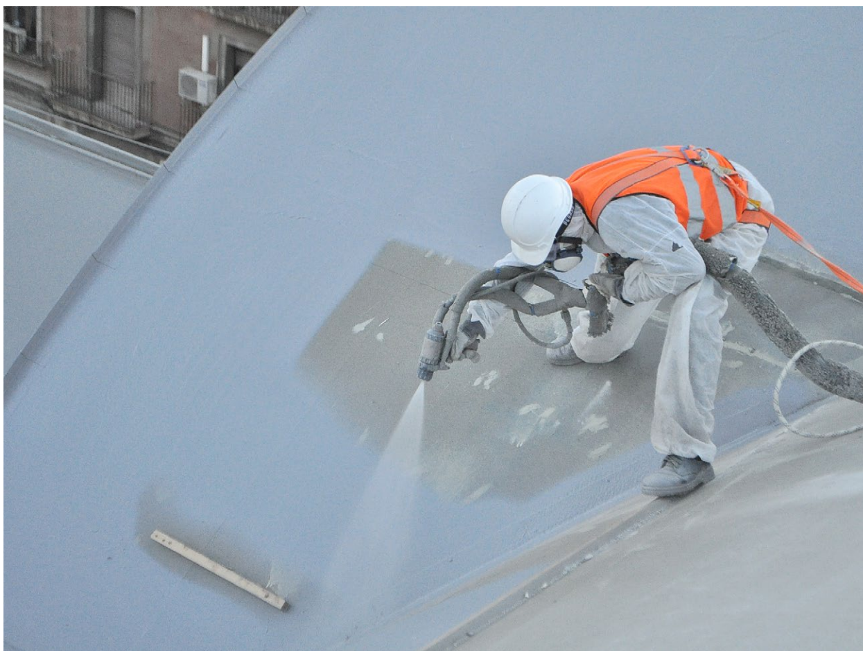
Proyección de una membrana de poliurea sobre chapa metálica
