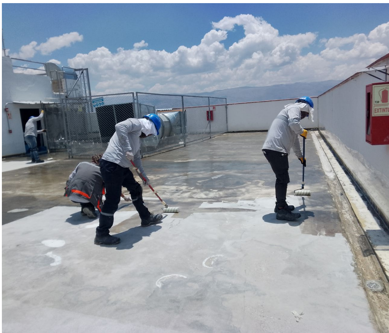
Aplicación de una imprimación epoxi con rodillo sobre un soporte regularizado
