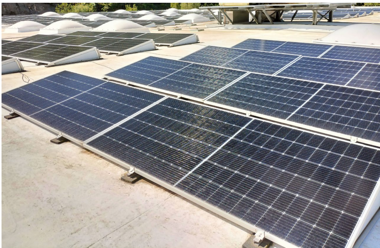
Rehabilitación de cubierta plana industrial con placas fotovoltaicas
