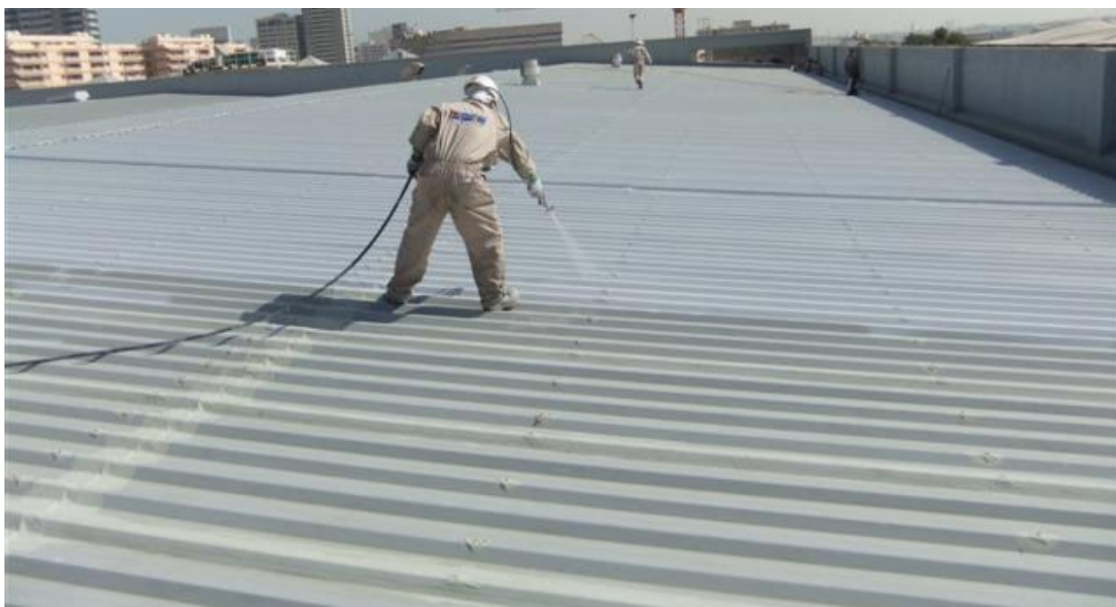
Proyección de una membrana de poliurea sobre chapa metálica
