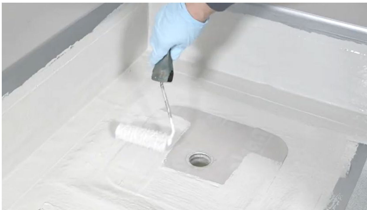
Sumidero prefabricado aplicado entre capas de poliuretano líquido
