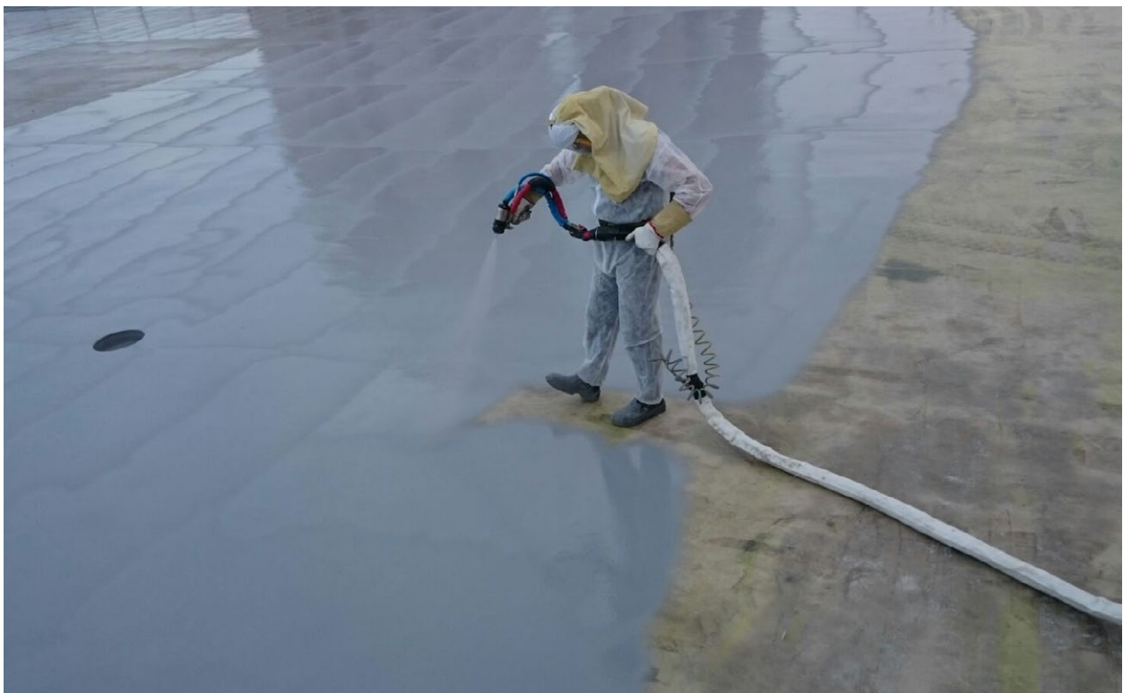
Aplicador proyectando poliurea con sistema de respiración asistida
