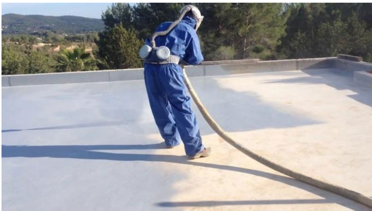
Aplicador de impermeabilización líquida en cubierta plana, equipado con los EPI de protección
