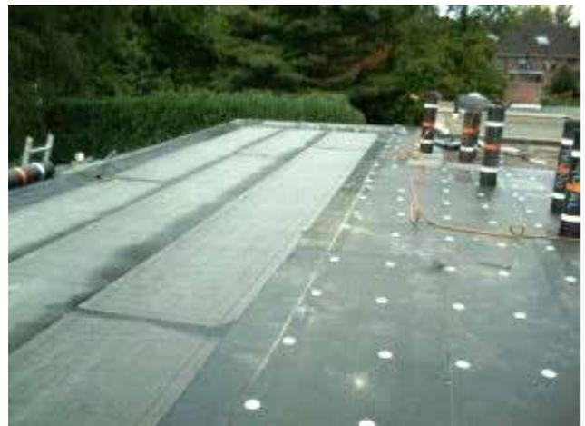
Tanto las fijaciones metálicas como las telescópicas están indicadas para este tipo de instalación. Se pueden seguir las recomendaciones anteriores en función del tipo de aislamiento que se emplee.
