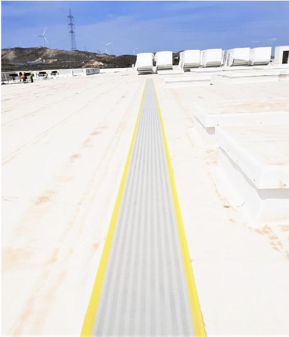
**Fotografía 34. Pasillo técnico en cubierta impermeabilizada con lámina sintética**
