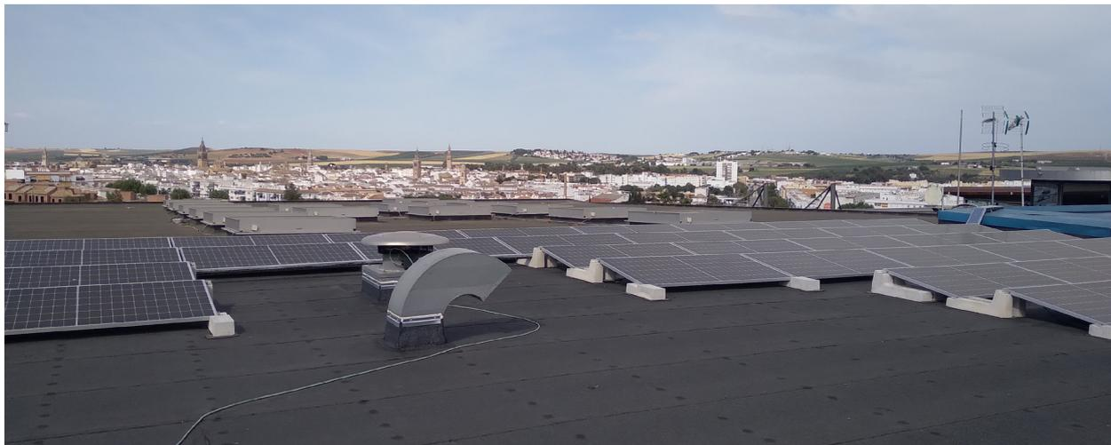
**Fotografía 2. Cubierta no transitable con impermeabilización bituminosa**
