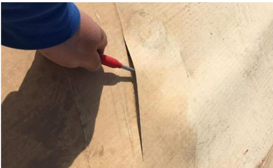
**Fotografía 30. Rotura de la lámina por contacto con elementos cortantes procedentes de los sistemas de soporte o elementos auxiliares. Falta de protección de la impermeabilización**
