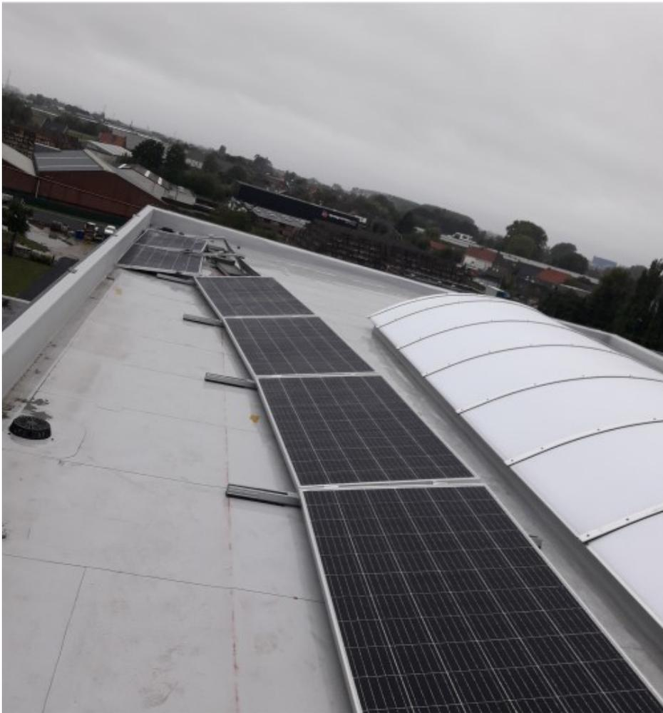
**Fotografía 28. Deslizamiento de los apoyos de los paneles solares**
