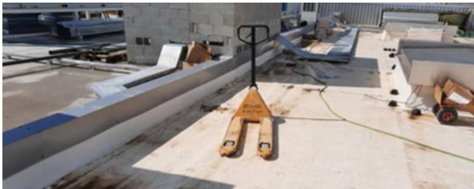
**Fotografía 31. Tránsito de maquinaria sin protección de la impermeabilización**
