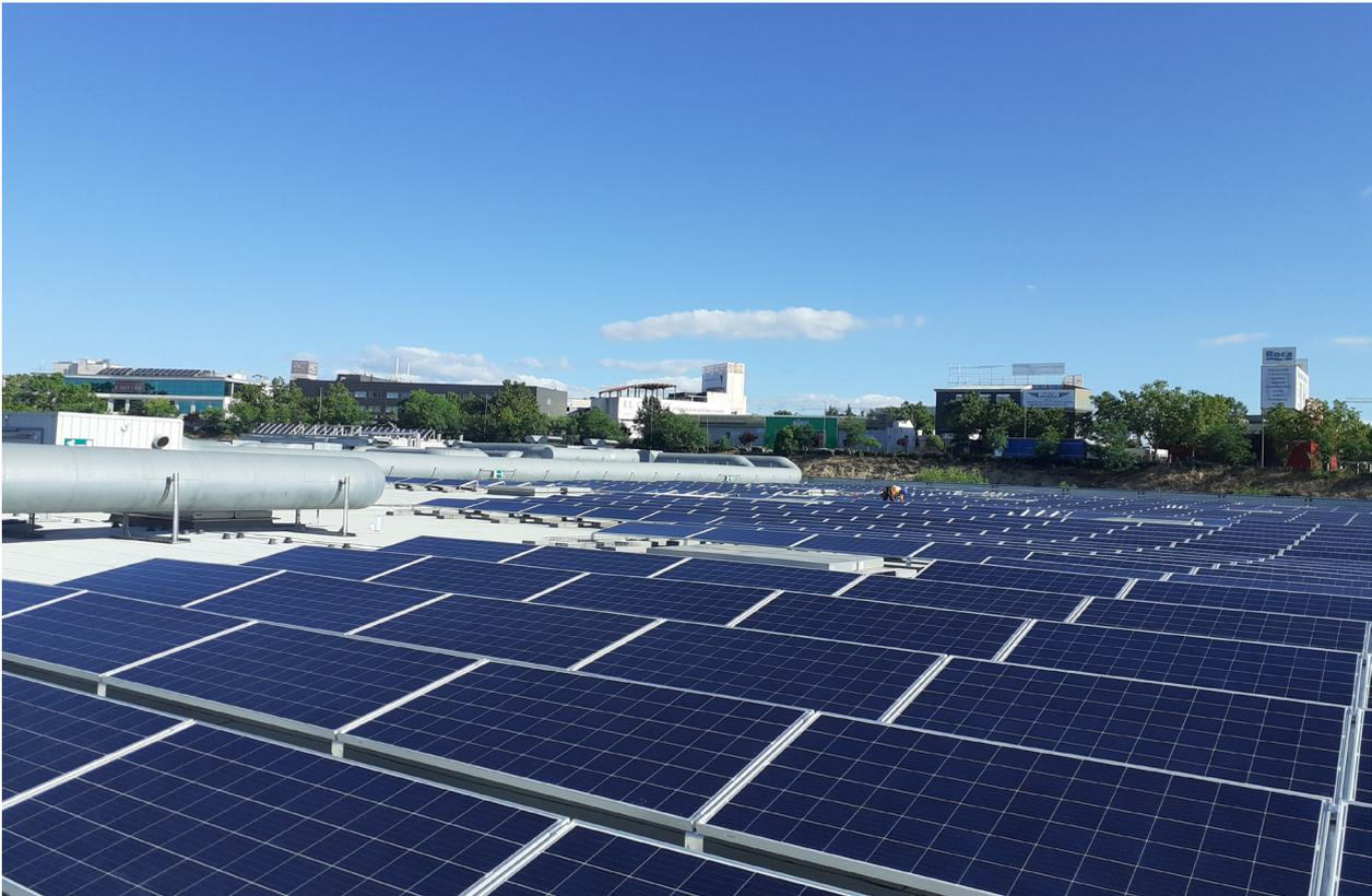
Fotografía 20. Sistema inclinado en cubierta plana no transitable
