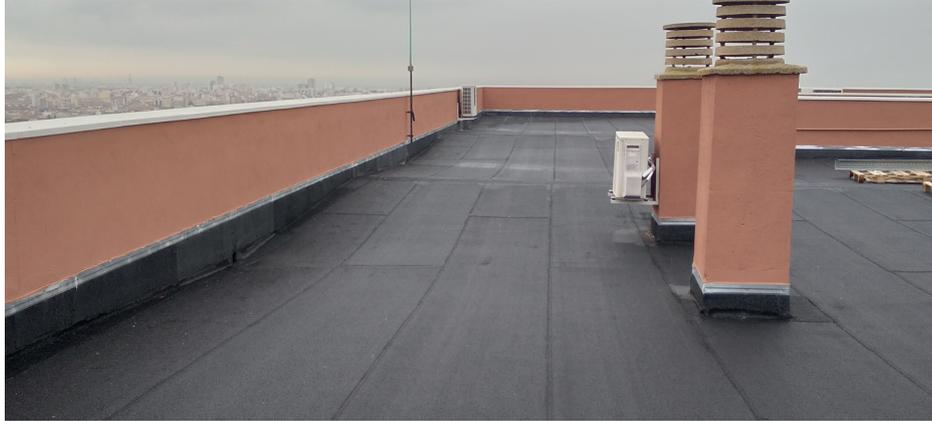
Fotografía 8. Sistema autoprotegido convencional con lámina asfáltica
