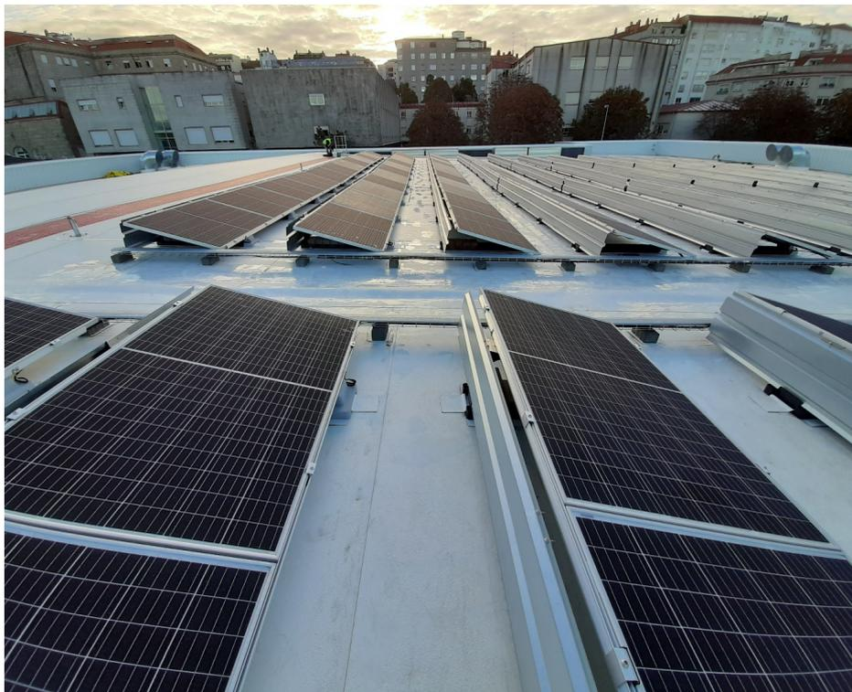
**Fotografía 19. Sistema de soporte mixto (soldado y lastrado) para paneles solares sobre una cubierta con impermeabilización sintética expuesta**
