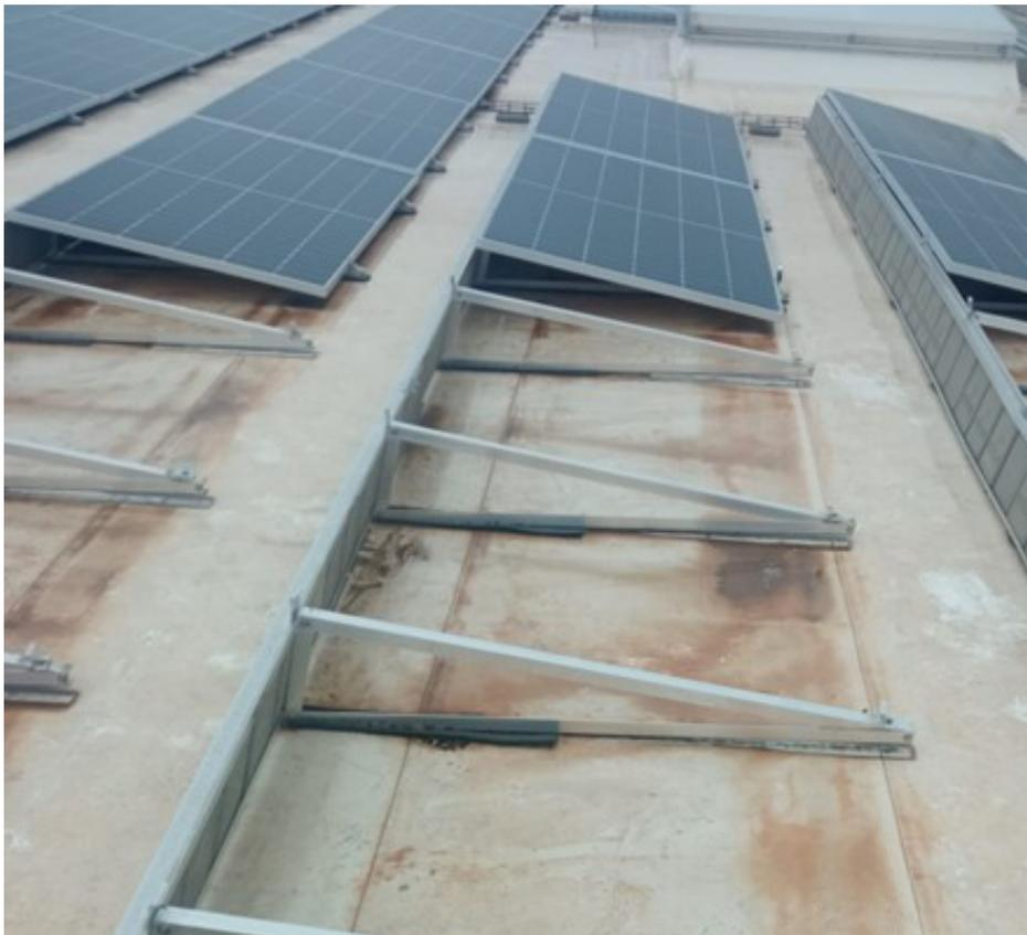
**Fotografía 29. Problemas de estanquidad y perforaciones por una inadecuada conexión con la lámina impermeabilizante**
