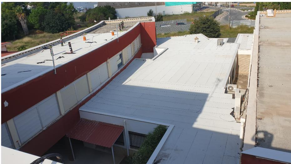
Fotografía 7. Cubierta no transitable con lámina fotocatalítica descontaminante y reflectante, autoprotégida (Alicante)
