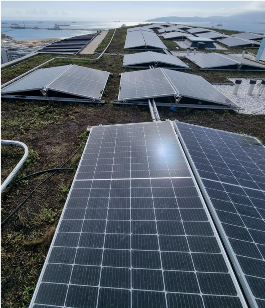
Fotografía 22. Sistema coplanar con inclinación en cubierta bio-solar
