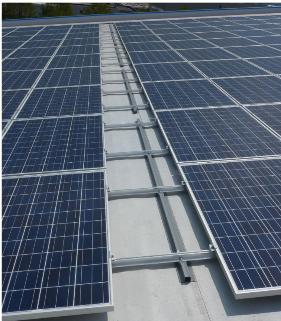
Fotografía 17. Sistema de soporte termofusionado o soldado para paneles solares sobre una cubierta con impermeabilización sintética expuesta
