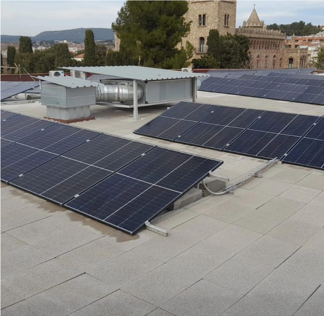
Fotografía 1. Cubierta transitable con paneles solares lastrados
