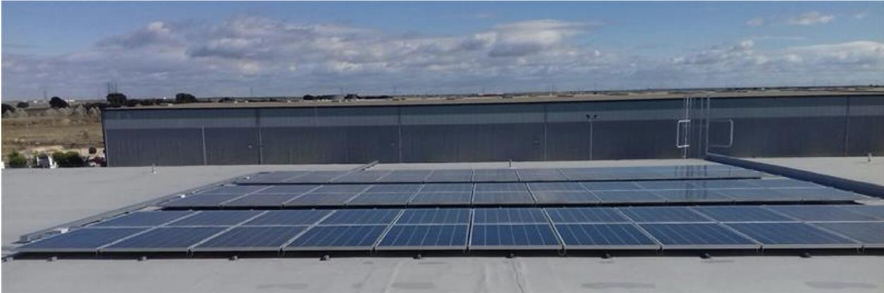
Fotografía 13. Cubierta solar con sistema de impermeabilización con lámina sintética
