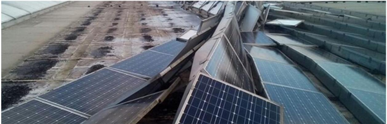
Fotografía 25. Paneles solares desplazados por la acción del viento en la cubierta
