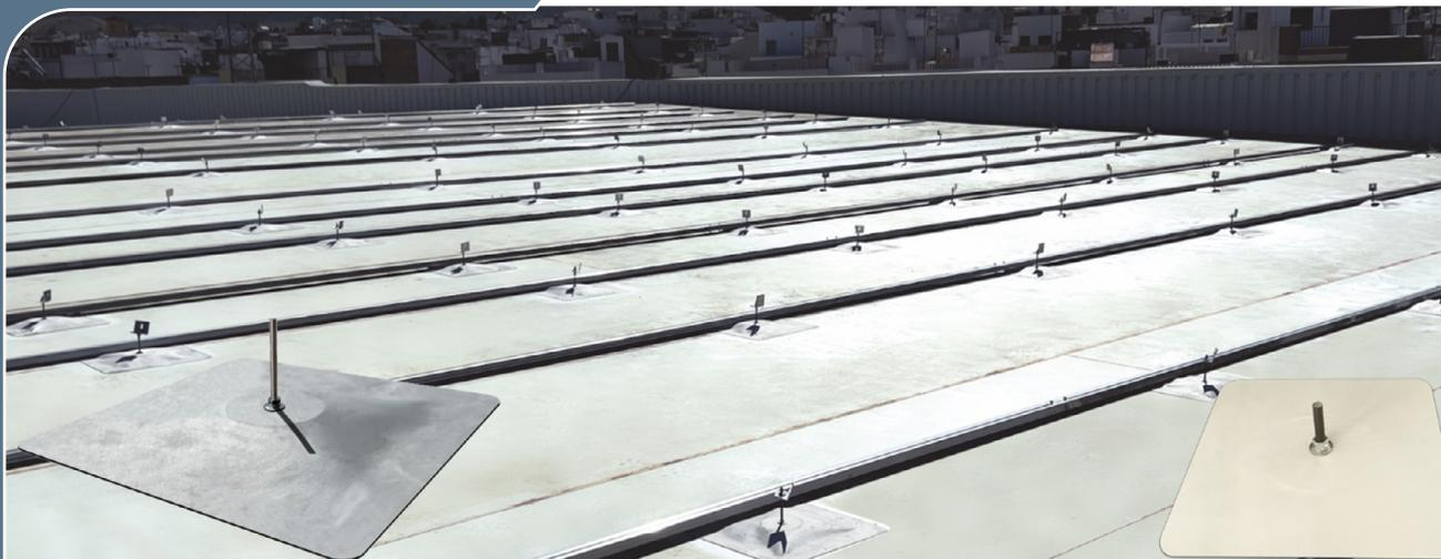
**DESCRIPCIÓN:** Sistema de fijación mecánica para cubiertas solares formado por una base metálica o de polipropileno tecnológico que se une mediante fijaciones mecánicas al soporte de la cubierta permitiendo resistir elevadas cargas de succión de viento sin añadir sobrepeso a la cubierta. Las piezas se impermeabilizan posteriormente con una pieza de remate del mismo material de la membrana de la cubierta quedando totalmente estancas.
