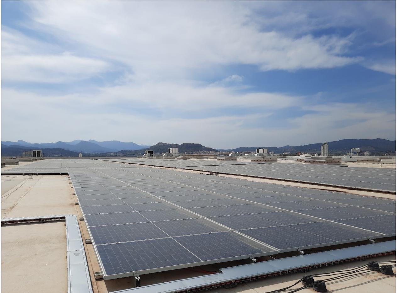
**Fotografía 21. Sistema coplanar en cubierta con impermeabilización sintética**
