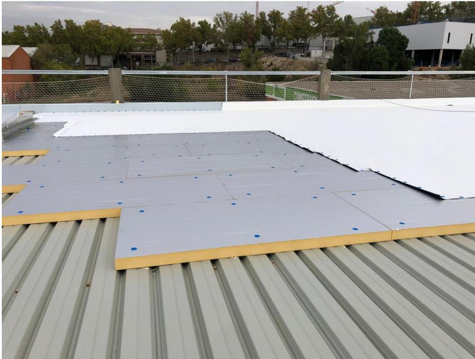
Fotografía 10. Cubierta plana con soporte metálico
