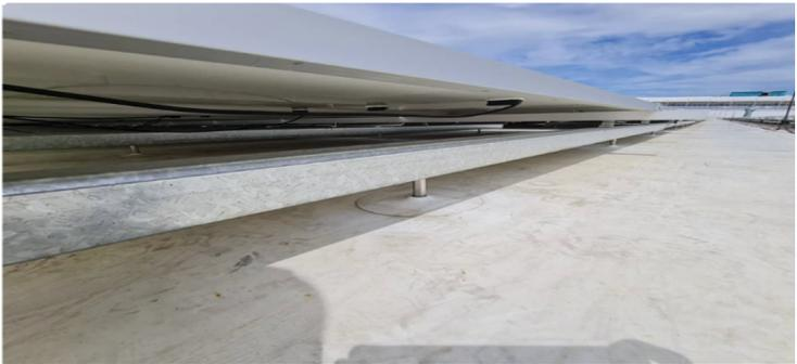
**DESCRIPCIÓN:** Sistema de fijación mecánica estructural preensamblado para cubiertas solares que proporciona una conexión segura mediante su anclaje al soporte resistente de la cubierta o a elementos estructurales, evitando transmitir así carga de viento adicional a la membrana impermeabilizante, creando una solución fiable y duradera.
