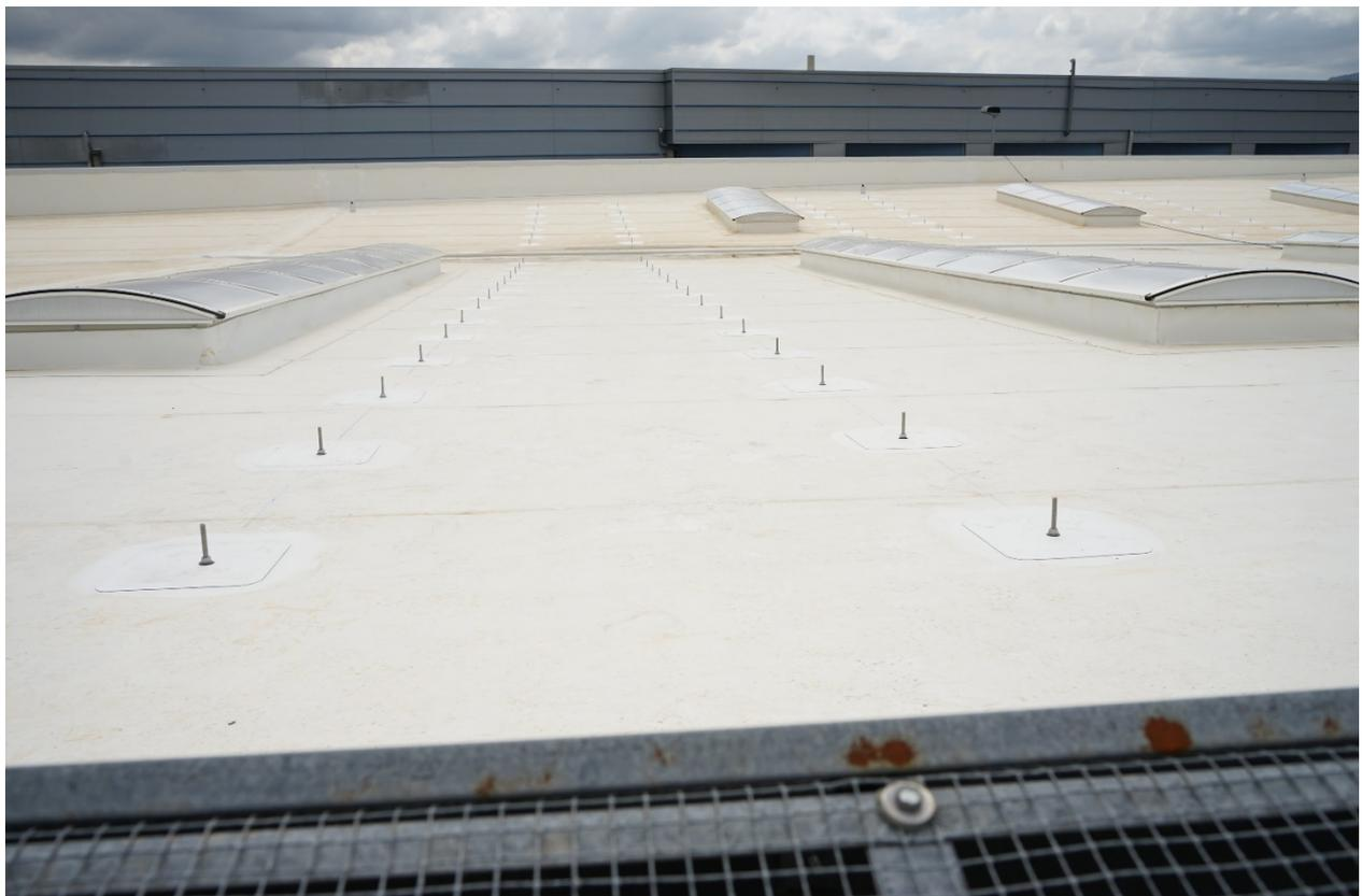
**Fotografía 16. Sistema de soporte fijado mecánicamente o anclado, para paneles solares sobre una cubierta con impermeabilización sintética expuesta**
