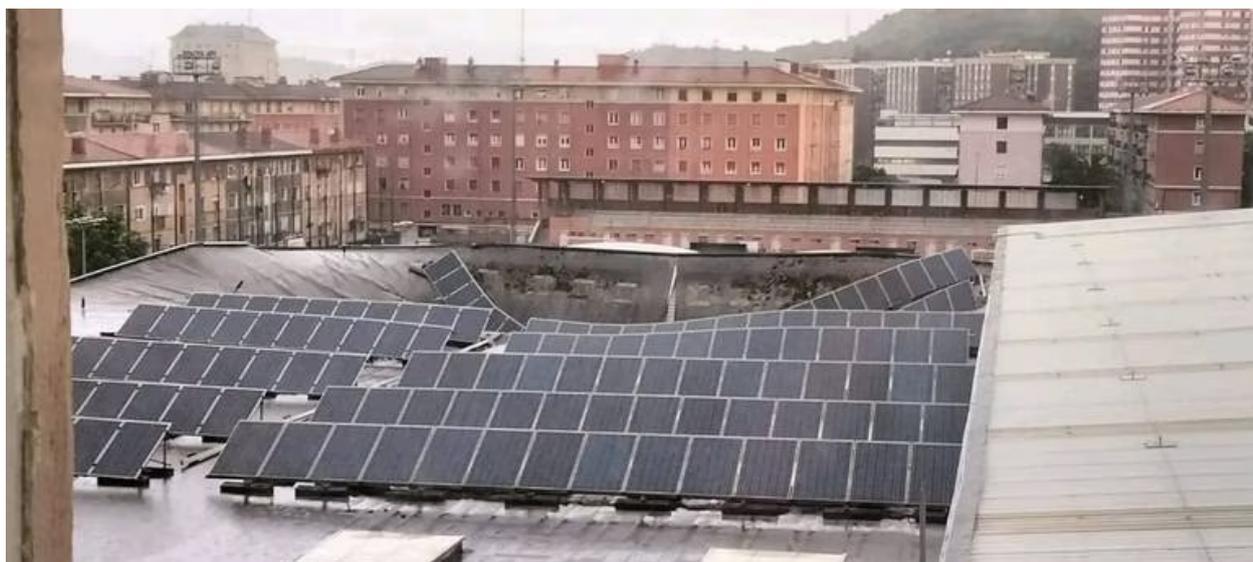
Fotografía 24. Derrumbe parcial de una cubierta solar
