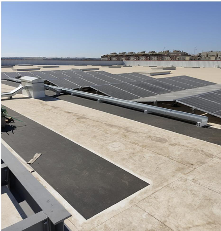
Fotografía 39. Pasillo técnico en cubierta solar impermeabilizada con lámina sintética
