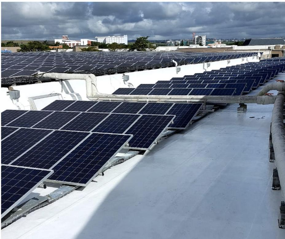
Fotografía 14. Cubierta solar con impermeabilización expuesta (membrana líquida)
