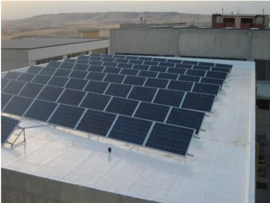
Fotografía 6. Cubierta plana con sistema Cool Roof
