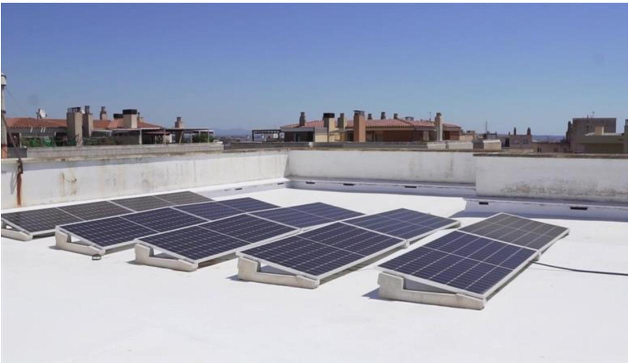
Fotografía 15. Sistema lastrado en cubierta con membrana de impermeabilización líquida
