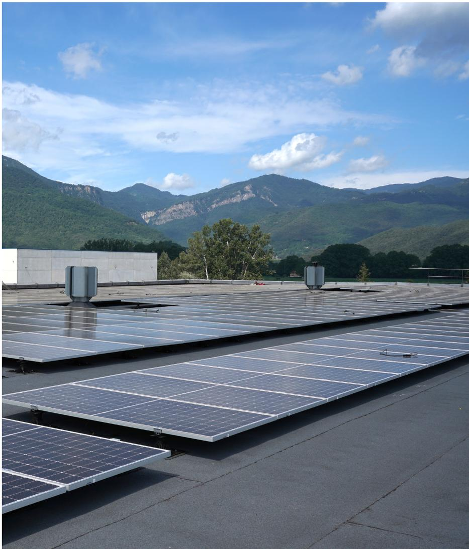
Fotografía 12. Sistema de cubierta solar con impermeabilización asfáltica
