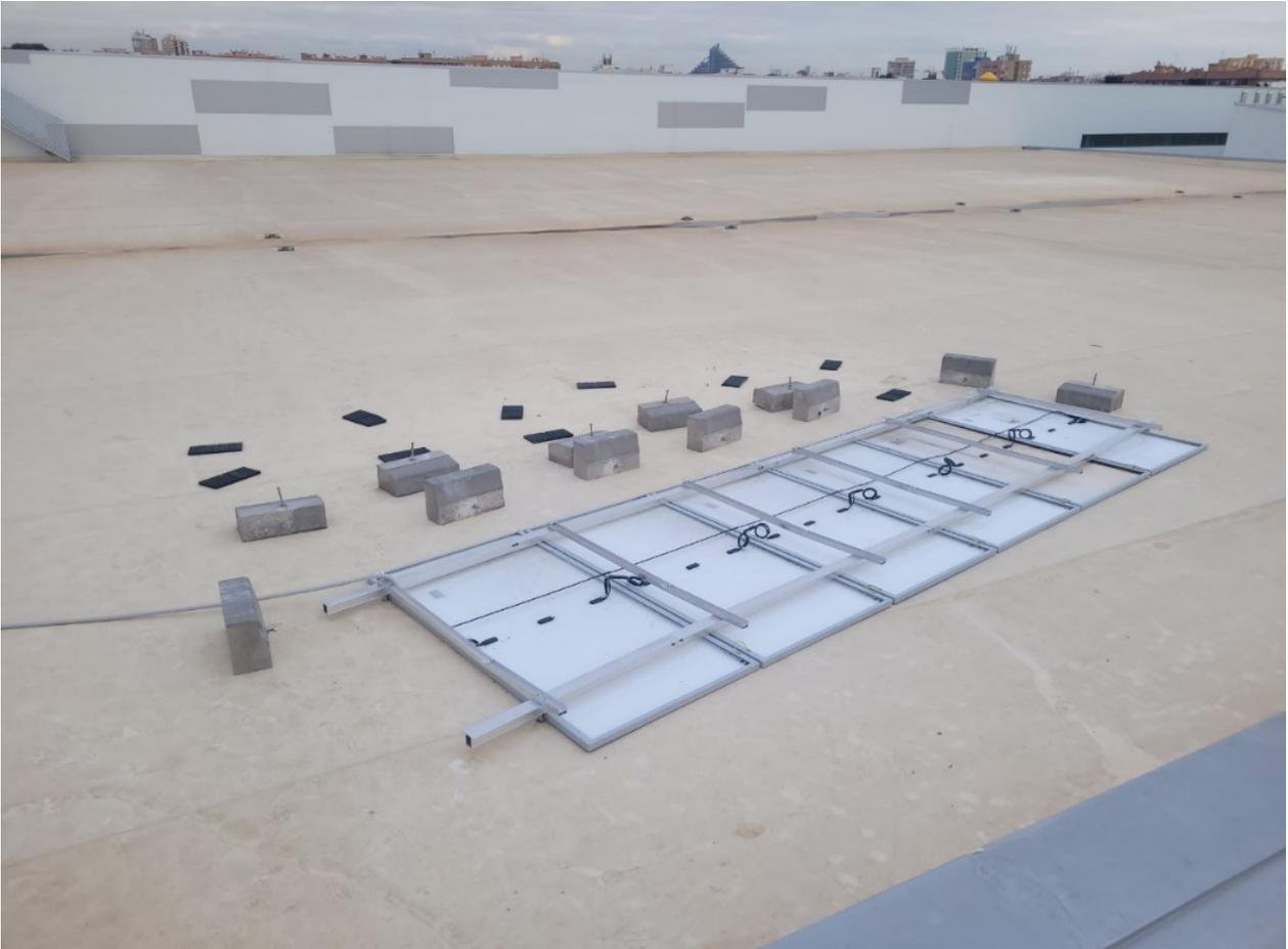
Fotografía 27. Paneles solares volteados por la acción del viento
