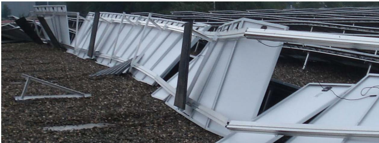
Fotografía 26. Paneles solares desplazados por la acción del viento en la cubierta
